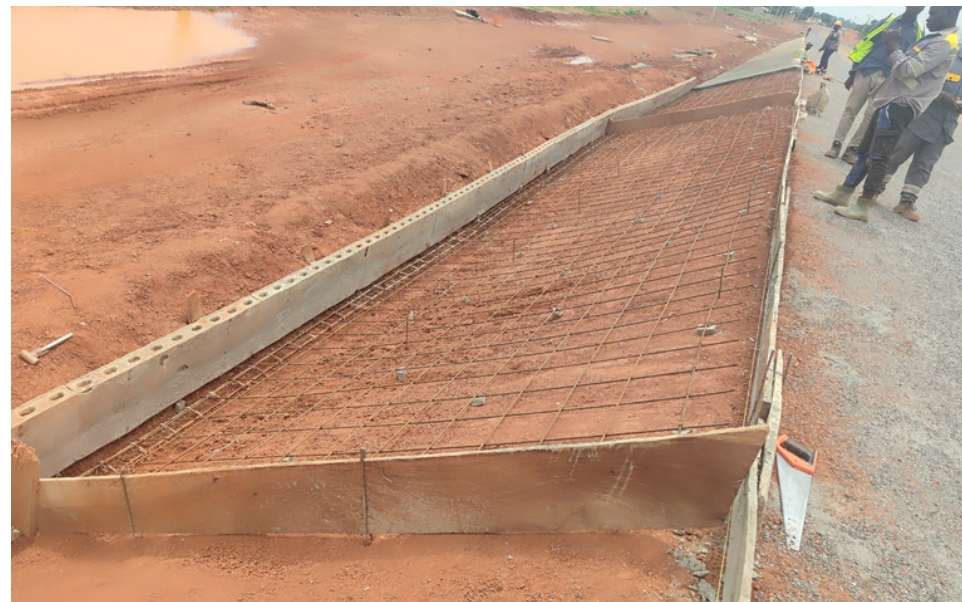
Photo 2 : Coffrage du talus en BA
