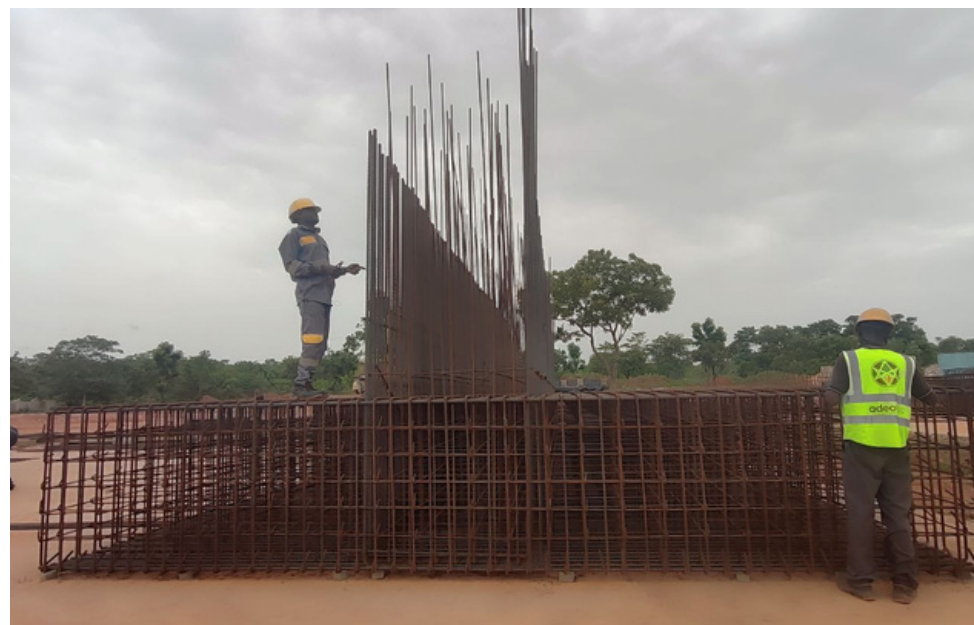
Photo 4 : Ferrailage de la semelle de la culée C0
