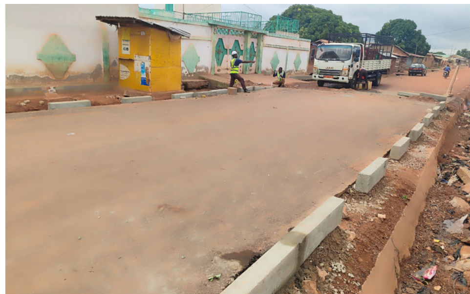
Photo 4 : BB au niveau de l'amorce du PK 0+ 189 CD et début de pose des bordures
