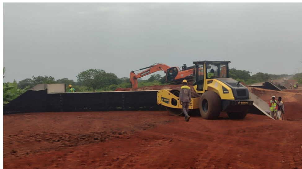
Photo 2 : Remblais techniques dans la zone de la batterie de 05 dalots
