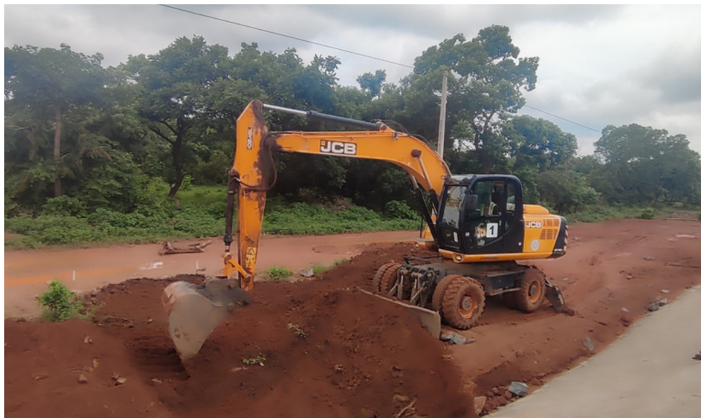
Photo 1 : Reprofilage d'exutoires d'ouvrages existants au PK 26
