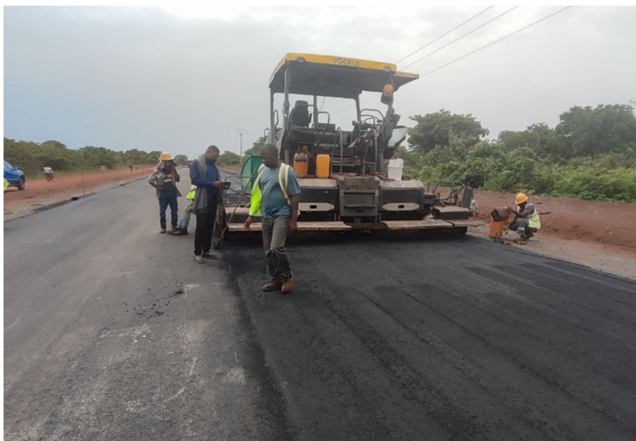
Photo 3 : Mise en oeuvre de la GB au PK 21
