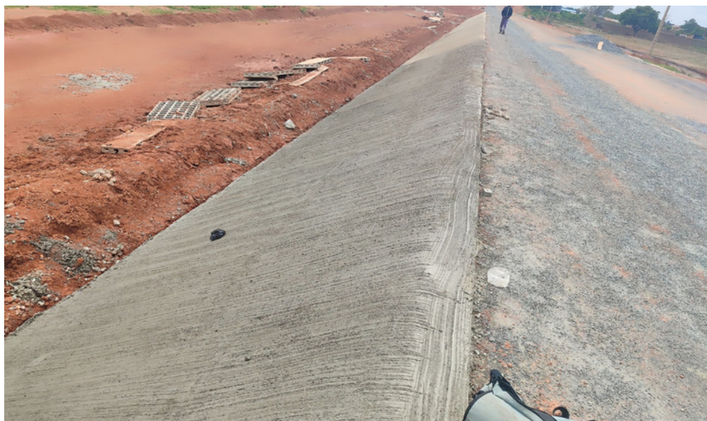
Photo 3 : Protection des talus en béton au PK 36
